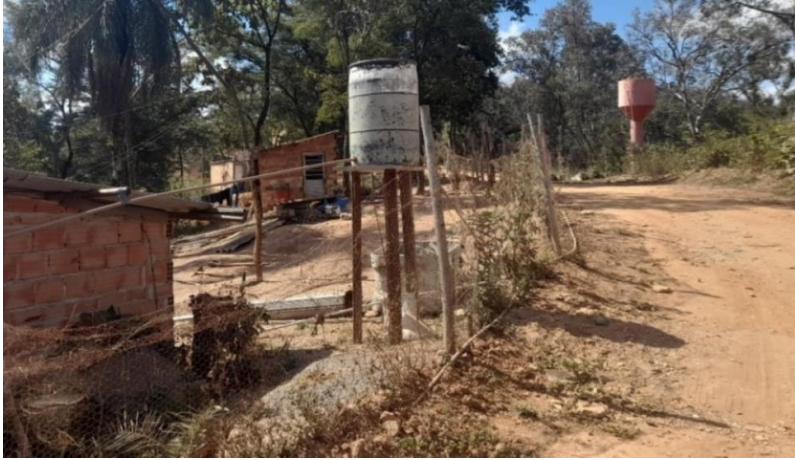
Rede de água aparente (rede não oficial)
